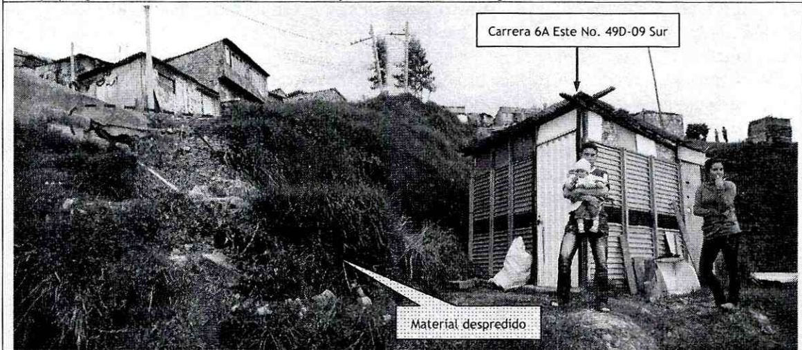
Foto 2. Se observa el material desprendido fue depositado en intermeditaciones del talud de corte y la vivienda emplazada en el predio con nomenclatura Carrera 6A Este No. 49D-09 Sur del Barrio San Martín de la Localidad de Rafael Uribe Uribe, comprometiendo el acceso a la misma.
