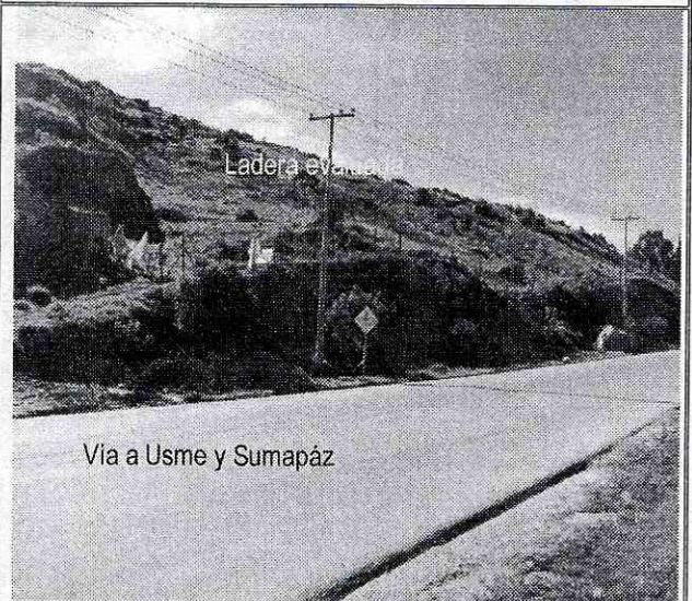
Foto 13. Imagen de la vía que conduce hacia el centro poblado de Usme y Sumapáz, la cual se puede ver afectada por caída de rocas y por material de proceso de remoción en masa de carácter general
