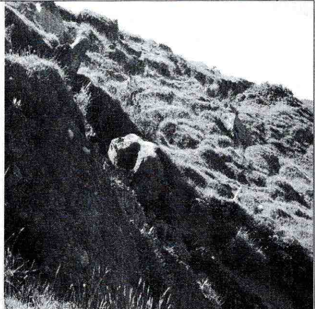
Foto 7. Detalle de una de las rocas observadas, la cual tiene un volumen cercano a los 3m 3 , la cual se encuentra apoyada sobre suelo inestable
