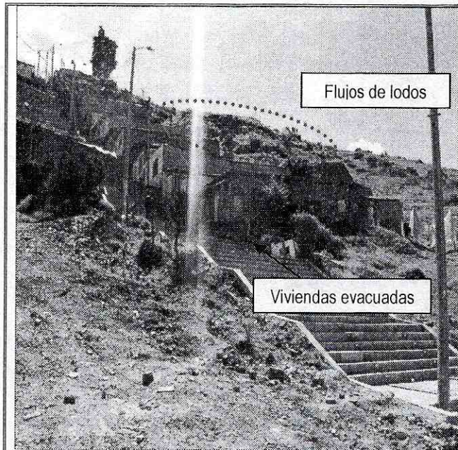
Foto 2. Vista desde la parte baja de la ladera donde se observan las viviendas del barrio Villa Anita III Sector, las cuales se encuentran dentro de la zona de influencia del proceso.
