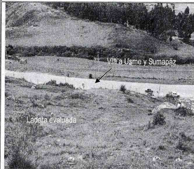
Foto 12. Vista desde la parte alta de la ladera desde donde se observa la vía que conduce hacia el centro poblado de Usme y hacia la localidad de Sumapáz, la cual puede ser afectada ante deslizamientos de rocas o por el avance del proceso de remoción en masa evidenciado
