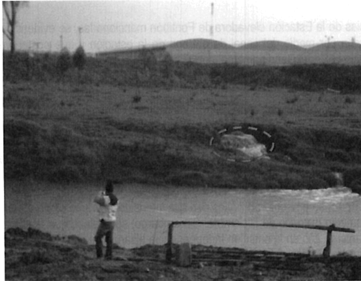
Foto 1. El interceptor Alsacia presurizado y descargando directamente al Canal Cundinamarca.
