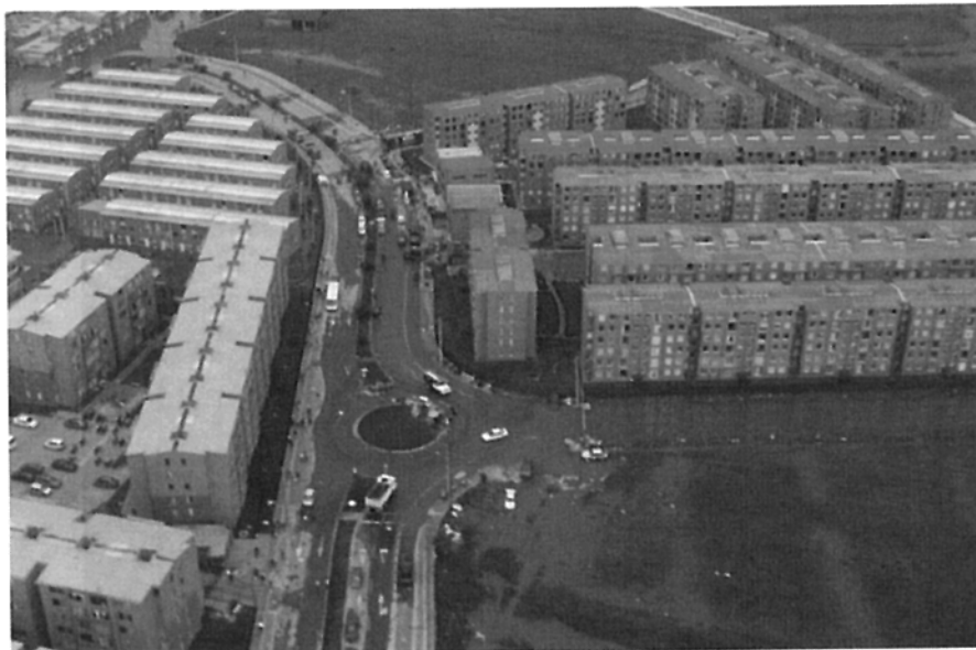
Foto 29. Zona afectada por la inundación en Kennedy
