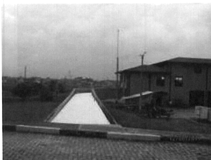
Foto 21. Espuma característica de agua residual en el canal de descarga de la estación elevadora Gibraltar
