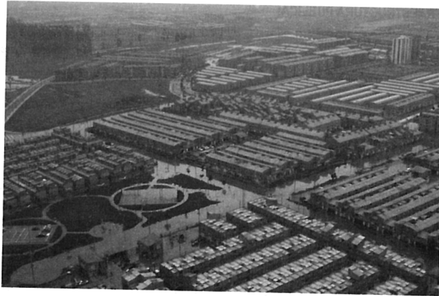
Foto 30. Zona afectada por la inundación en Kennedy
