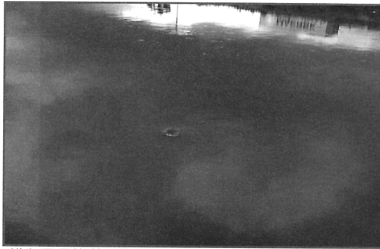
Foto 11. Vórtice que evidencia el ingreso del agua del río Fucha hacia la estación de bombeo Fontibón.
