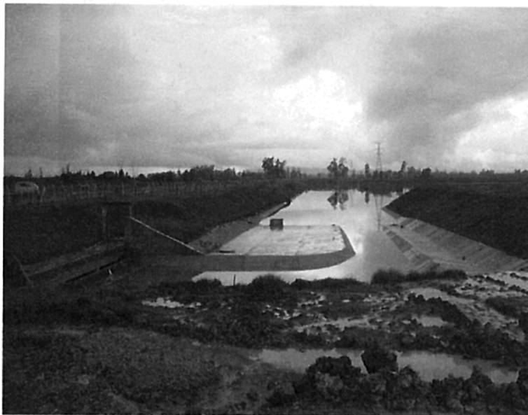
Foto 12. Pondaje La Magdalena. Niveles inferiores a los vistos el 24 de noviembre producto del bombeo realizado al canal Cundinamarca
