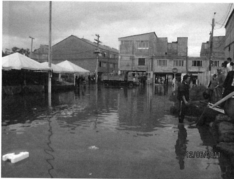
Foto 26. Afectación inundación viviendas por reflujos del canal Cundinamarca y afluentes en Kennedy
