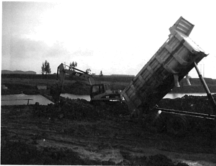
Foto 4. Construcción de la cámara norte del box coulvert que atraviesa el canal Cundinamarca.
