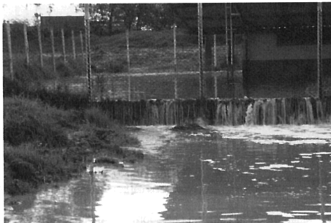
Foto 10. Estación elevadora Fontibón Inundada
