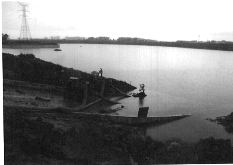
Foto 5. Estaciones móviles de bombeo evacuando el agua del pondaje La Magdalena hacia el Canal Cundinamarca
