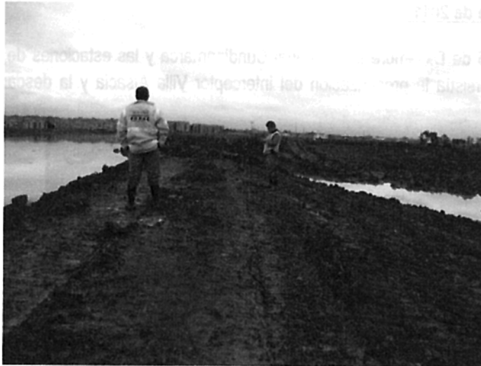
Foto 7. Reconformación provisional de un sector del jarillon izquierdo del río Fucha, situación de desbordamiento del río.
