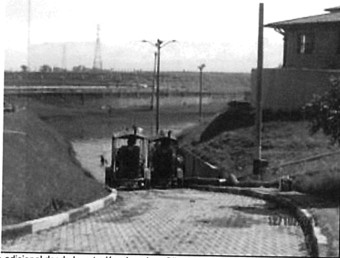
Foto 31. Bombeo adicional desde la estación elevadora Gibraltar, vista desde el canal Cundinamarca (10 Dic. 2011).
