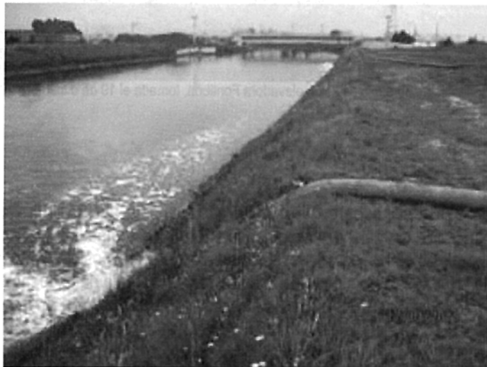
Foto 36. Descarga de las tres bombas instaladas en la estación elevadora Fontibón hacia el río Fucha
