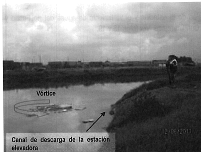
Foto 20. Vórtice de succión del agua desde el río Fucha a través del canal de descarga de la estación elevadora Fontibón
