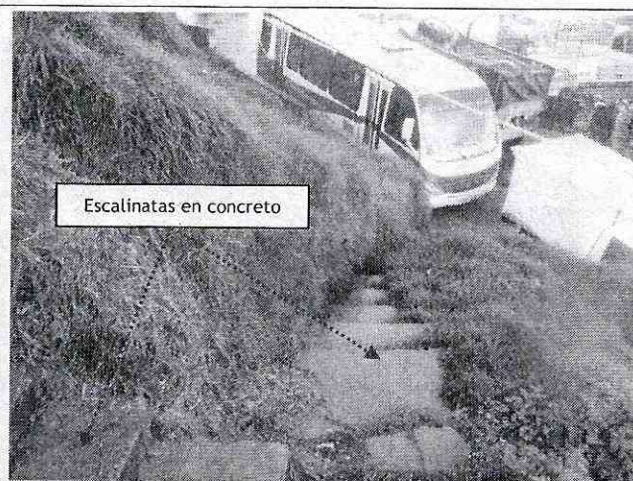
Fotos 5 y 6. Vista del proceso del remoción en masa en masa, el cual en su superficie de falla dejó expuesta la red de gas de diámetro aproximado \Phi \frac{1}{2} ” y la acometida de acueducto del predio con nomenclatura Carrera 20 No. 70N-15. Adicionalmente, se puede evidenciar que el material movilizado, se depositó en los dos senderos peatonales en escalínatas en concreto que conducen desde la Carrera 20 hacia las viviendas emplazadas en la parte alta del talud de corte donde se presentó dicho proceso.
