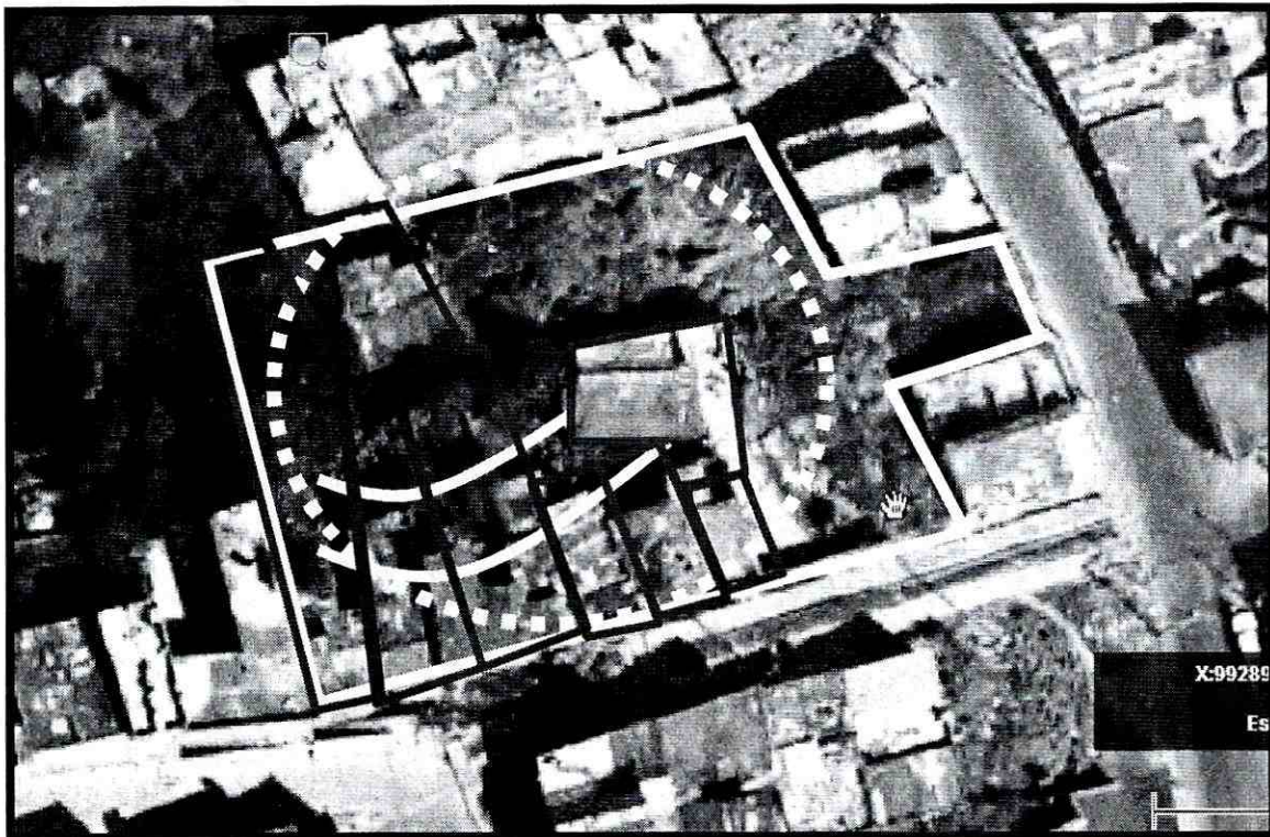
Figura 1. Aerofotografía del sector donde se localizan los predios evaluados y delimitación del polígono de afectación debido al proceso de remoción en masa identificado.
