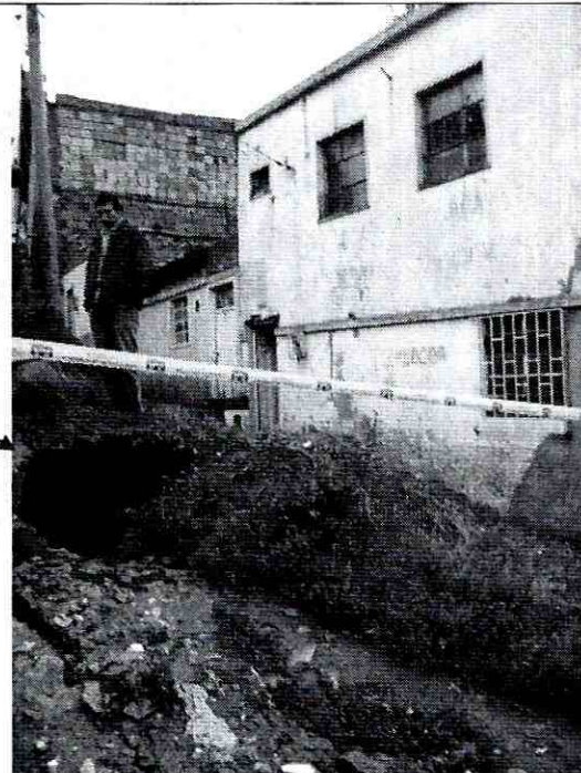
Foto 4 y 5. Hundimiento del terreno que generó un hueco muy cerca de las viviendas y que aumento la inestabilidad del sector.
