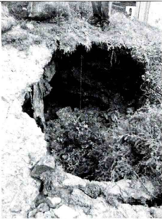
Foto 4 y 5. Hundimiento del terreno que generó un hueco muy cerca de las viviendas y que aumento la inestabilidad del sector.
