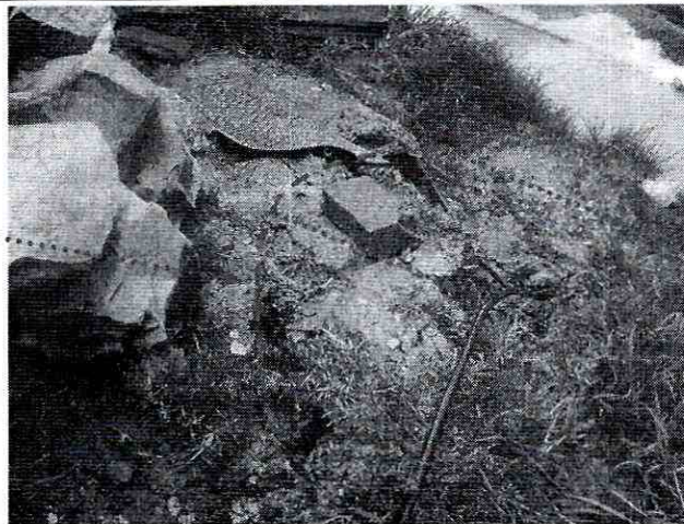
Fotos 2 y 3. Vista de la parte alta del talud de corte, donde se observan las grietas que demarcan un proceso de remoción en masa activo de carácter local, que involucra un volumen aproximado de material de aproximadamente 3 m 3 de suelo orgánico y cobertura vegetal.
