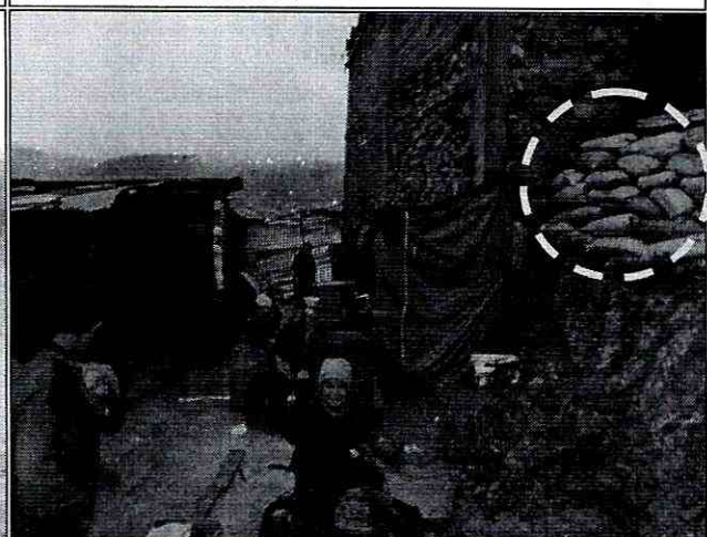
Foto 4. Detalle del interior de la vivienda de la Calle 82 C Bis Sur No. 44 B - 28 y 34 (Lotes 11 y 12 de la manzana 91), donde se aprecia hacia el costado oriental una serie de sacos de tierra apilados como posible medida de contención del talud de corte superior.
