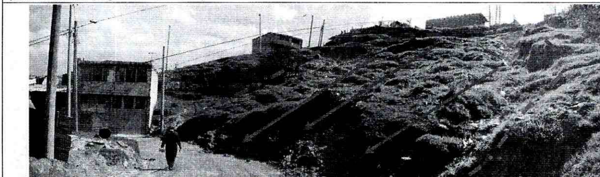
Fotografía 2. Proceso de inestabilidad en el sector de la Calle 48 D Sur con 12 B, costado sur-oriental de la vía de acceso al Barrio Villas del Recuerdo. (Diciembre de 2011)
