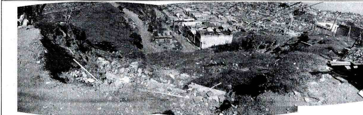
Fotografía 3. Vista desde la Carrera 12 B del proceso de inestabilidad en el sector de la Calle 48 D Sur con 12 B, costado sur-oriental de la vía de acceso al Barrio Villas del Recuerdo. (Diciembre de 2011)
