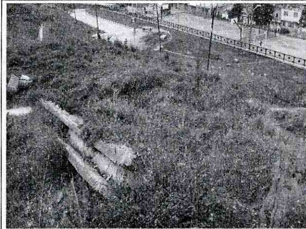
Fotos 3 y4. Se observa las afectaciones en la reconformación del talud y las obras de drenaje superficial para el manejo y control de las aguas de escorrentía y la malla utilizada para la revegetalización del talud, generadas por los procesos de remoción en masa identificados en el talud del parque Zonal Diana Turbay, ubicado en la Calle 48X Sur entre la Carrera 1 Este y la Carrera 1C
