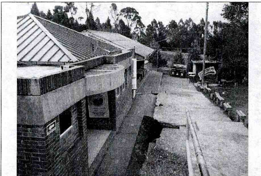
Foto 1. Instalaciones del Colegio El Verjón Bajo I.E.D donde se evidencia que al momento no presenta afectaciones que puedan comprometer la estabilidad y funcionalidad del mismo, debido a los procesos de remoción en masa identificados.
