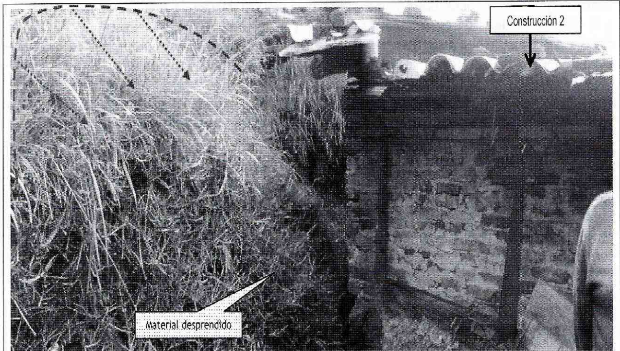
Foto 2. El volumen involucrado en el proceso de remoción en masa es de aproximadamente 5 m 3 , el cual se depositó en la parte baja del talud de corte e impactando el muro perimetral del costado Sur-Oriental de la edificación identificada en la Figura 1 como construcción 2 y obstruyendo el ingreso a la misma, sin presentar afectaciones en su estructura.
