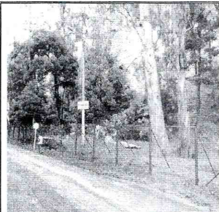
Foto 5. Vista del escarpe ubicado al costado oriental de de la Transversal 2 Este No. 77-91 donde se dispuso una estructura de trinchos a la parte baja del escarpe y se realizó la adecuación de la malla eslabonada que perdió funcionalidad por causa del desprendimiento del día 24 de Octubre de 2011.
