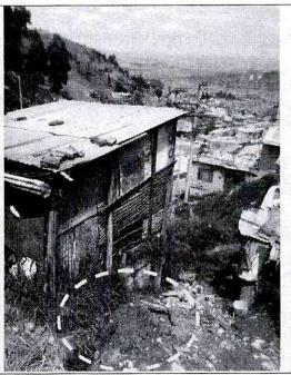
Foto 2. En el costado norte del predio de la Transversal 5F Este No. 49D 63 Sur, se observa el manejo inadecuado de aguas de escorrentía superficial, lo que posibilita e incrementa la saturación del talud de relleno donde se emplaza la vivienda en mención.
