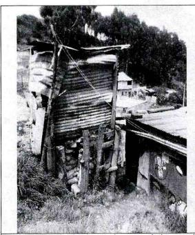
Foto 1. Vista desde el costado norte, de la zona de baño del predio de la Transversal 5F Este No. 49D 63 Sur. Se observan deficiencias constructivas de la vivienda y perdida de verticalidad de los elementos de madera y tejas de zinc que sirven de cerramiento de la vivienda.
