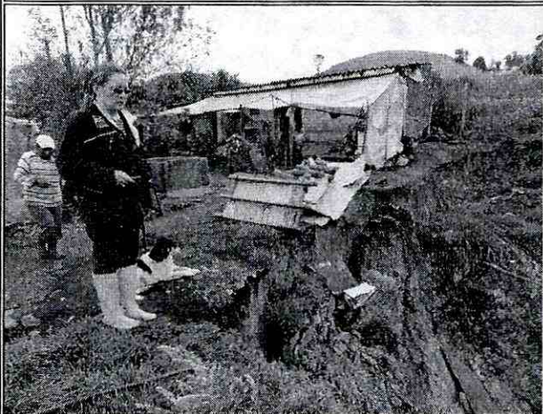
Foto 4. Costado Norte de la corona del deslizamiento, localizada muy cerca a los muros de cerramiento de la vivienda emplazada en la finca San Antonio.
