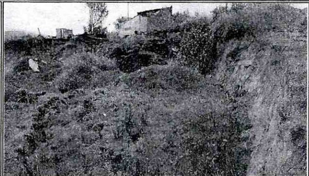
Foto 3. Detalle del escarpe principal del deslizamiento. Se aprecian además grietas transversales y escarpes secundarios en la zona hundida.
