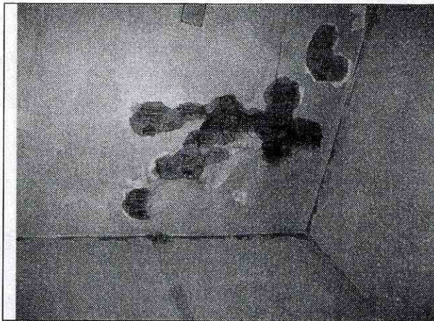
Foto 5 y 6. Vista de habitaciones donde se presentan desprendimientos parciales del cielo raso
