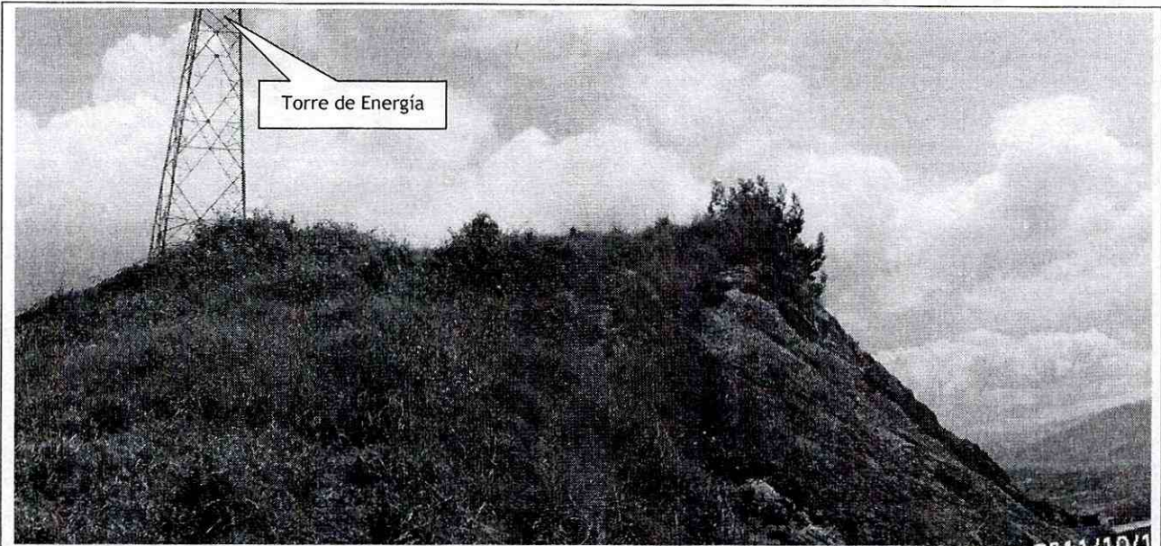
Foto 17. Se observa hacia el costado Norte del antiguo frente de explotación minera una torre de energía a una distancia aproximada de 50 m del mismo, la cual se encuentra fuera de la zona de influencia por los procesos de remoción en masa identificados en dicho frente de explotación.
