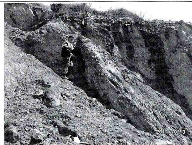
Foto 14. Se observa que el material se moviliza a lo largo de los planos de estratificación que buzan en el mismo sentido de la pendiente, favoreciendo el proceso de inestabilidad evidenciado.
