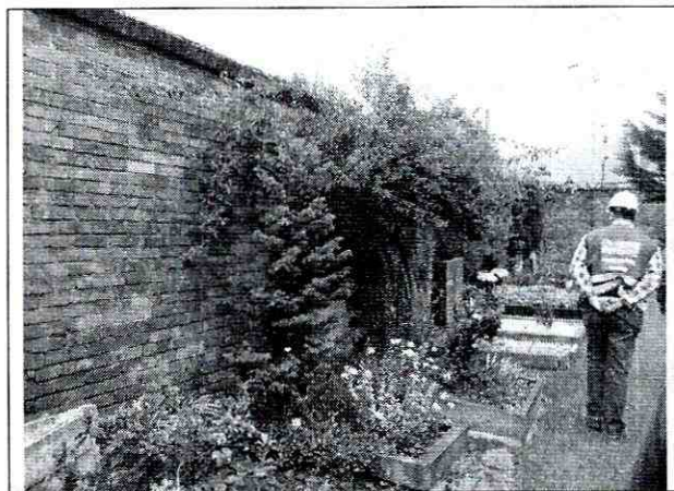
Foto 4. Tramo del muro del costado suroriental, visto desde el interior del predio de la Calle 26 No. 22-75 (Cementerio Alemán)..
