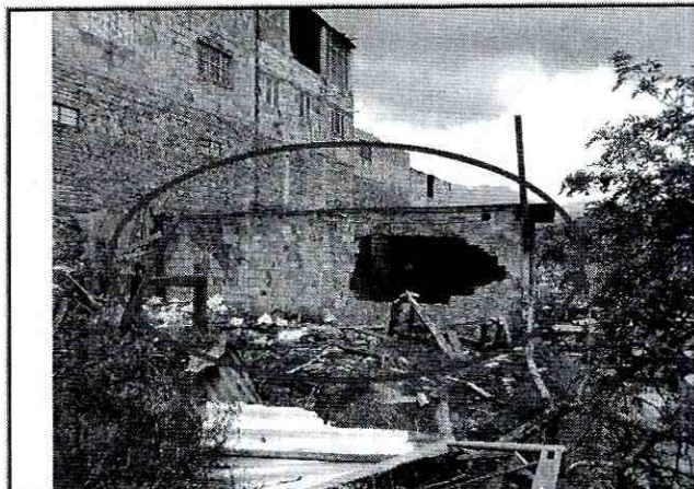
Fotografía 5. Vista de la vivienda parcialmente demolida, emplazada en el predio de la Diagonal 37A Sur # 16 – 28 INT 1, el cual fue incluido al programa de reasentamiento con ID – 2008-18-10906.
