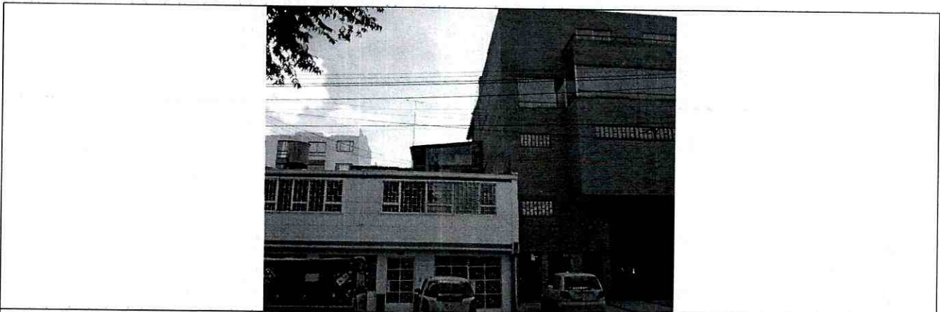
Fotografía No. 1. Vista general de la vivienda emplazada en la Calle 161 No. 21 - 55 y Calle 161 No. 21 65 en el Barrio Orquídeas de la Localidad de Usaquén.
