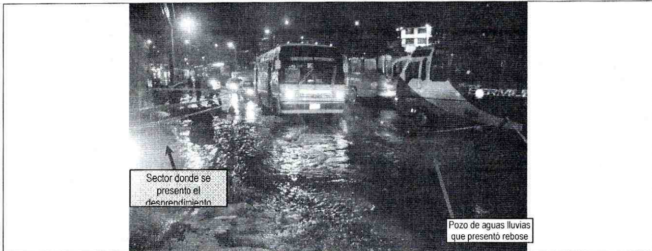
Fotografía 1. Vista desde el costado sur del puente vehicular ubicado sobre la Carrera 1 (Avenida Caracas) y la Quebrada Yomasa
