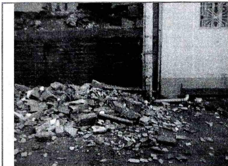
Foto 3. Material de escombros que se depositó sobre la Diagonal 27 D Sur
