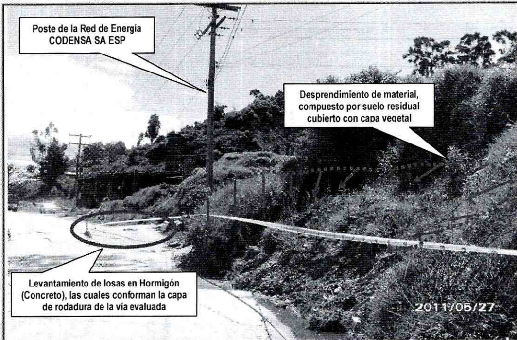
Fotografía No. 4. Vista general del segundo talud de corte que presentó desprendimiento de material, localizado al costado oriental de la Avenida Carrera 13 A Este entre la Calle 28 B Sur y la Calle 29 Sur del Barrio Amapolas de la Localidad de San Cristóbal.
