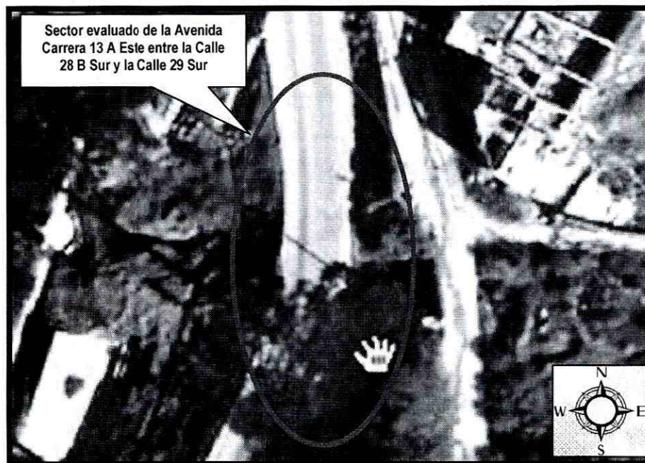
Fotografía No. 1. Sector evaluado de la Avenida Carrera 13 A Este entre la Calle 28 B Sur y la Calle 29 Sur, en Atención al Evento de Emergencia SIRE No. 114422 del 27 de Mayo de 2011, de acuerdo con el Plano Normativo de Amenaza por Remoción en Masa del Plan de Ordenamiento Territorial de Bogotá - POT
