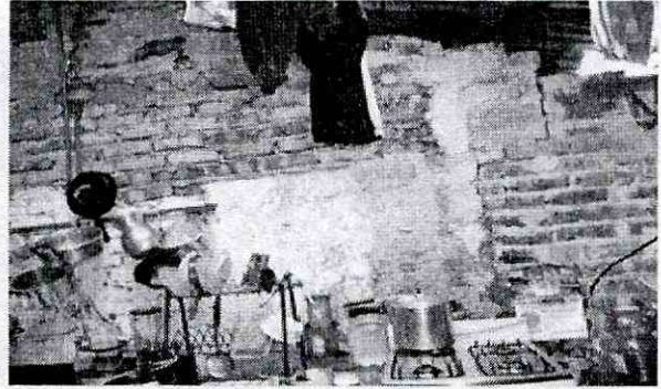
Fotografía No.3 y 4.predio de la Carrera 17 G Este No. 30-59 Sur Manzana 20 Lote 19 donde se evidencia pérdida de verticalidad y agrietamiento en muros que conforman una zona de la vivienda y hundimiento en la placa de contra-piso
