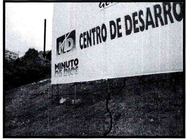
Fotos 3 y 4 . Detalle de la inclinación de la valla, y referencia co la línea de acción del escarpe.
