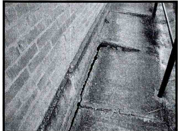
Fotos 5 y 6. Detalles de las afectaciones en la mampostería vecina al ingreso del bloque y en la rampa.
