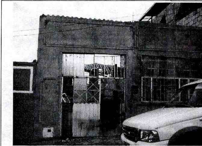
Foto 1. Fachada principal del predio de la Carrera 11 Este # 45-55 Sur.
