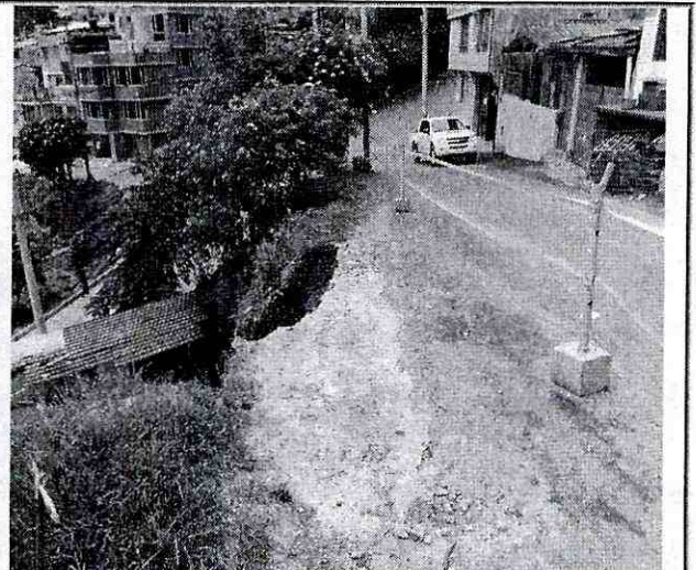
Fotografía No. 2. Vista del sendero peatonal ubicado en la parte alta del talud, sobre la Carrera 2A a la altura de la Calle 127B.
