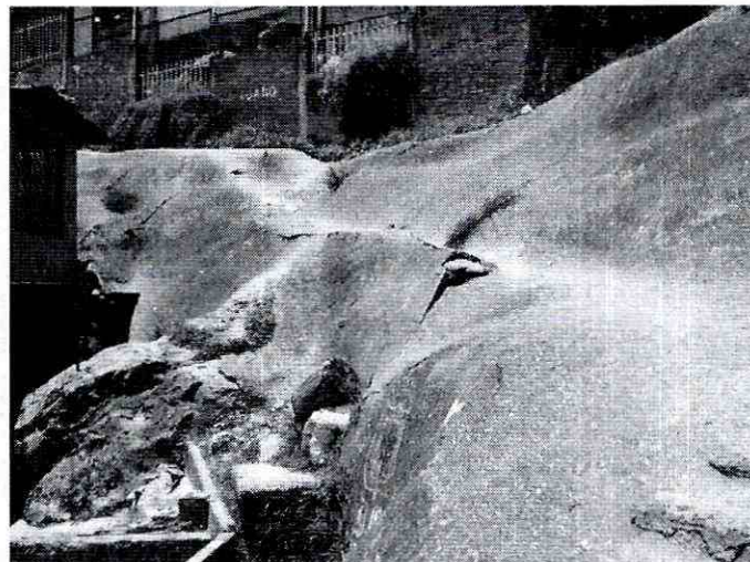
Foto 26 y 27. Se observa el sector aledaño al área donde se encuentra emplazado el predio de la Carrera 17N Bis No. 79-37 Sur, un talud de aproximadamente 10 m de altura con pendiente aproximada de 40°. Donde se realizaron obras de estabilización. Las mismas se observan deterioradas.
