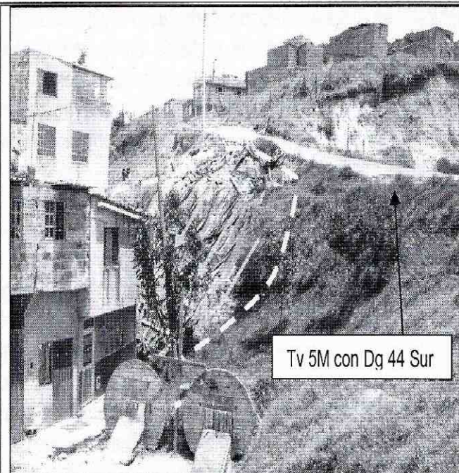
Fotografía 2. Vista frontal del sector afectado por el desconfinamiento del terraplén, donde se aprecia el desconfinamiento del terraplén en su costado Sur
