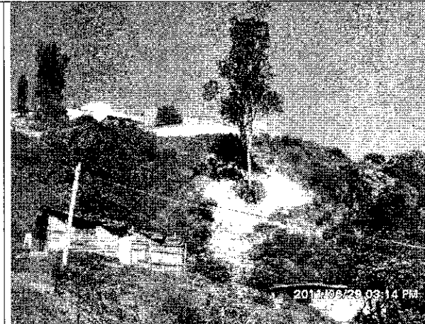
Foto 4. Se puede identificar que ante la eventual caída del árbol y la posible trayectoria, se podría ver afectada la vivienda evaluada.
