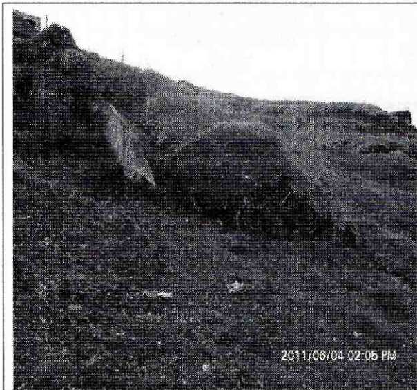
Foto 4. Se observa que los avances del proceso han causado deformaciones considerables en el terreno.
