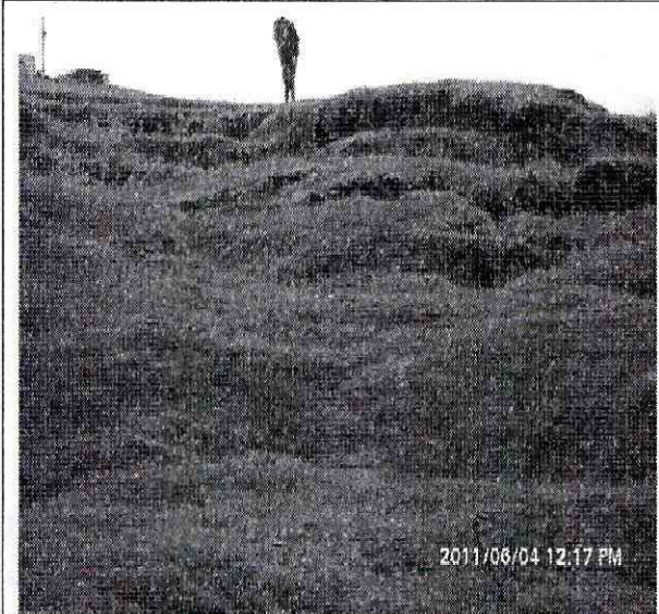
Foto 6. Se observan múltiples escarpes a lo largo y ancho del terreno afectado por el proceso de remoción en masa.
