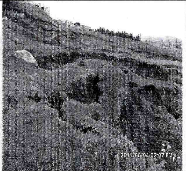
Foto 7. Se observan múltiples escarpes a lo largo y ancho del terreno afectado por el proceso de remoción en masa.
