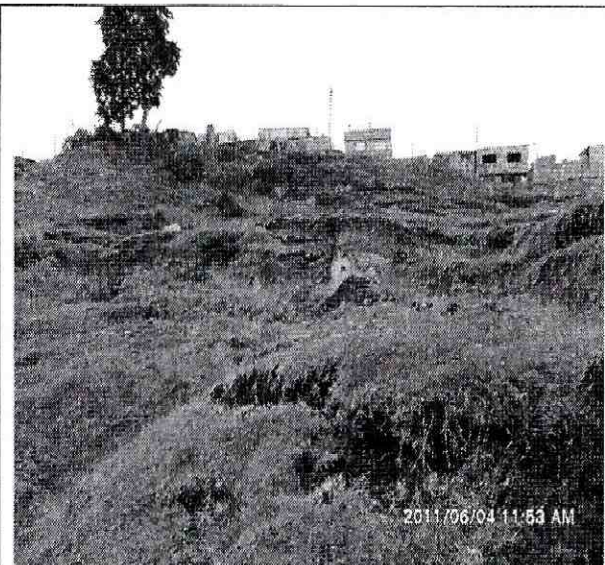
Foto 8. Se observan múltiples escarpes a lo largo y ancho del terreno afectado por el proceso de remoción en masa.
