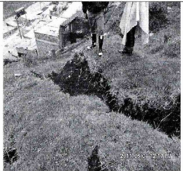
Foto 5. Se observan grietas de tracción de hasta 30 cm de abertura a lo largo y ancho del proceso de remoción en masa.
