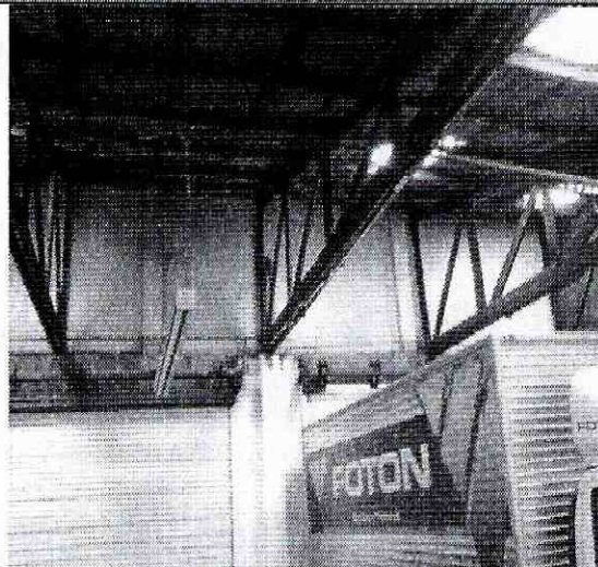
Fotografías 7 y 8. Se observa la cubierta a media altura del muro evaluado, apoyada sobre estructura en madera.
