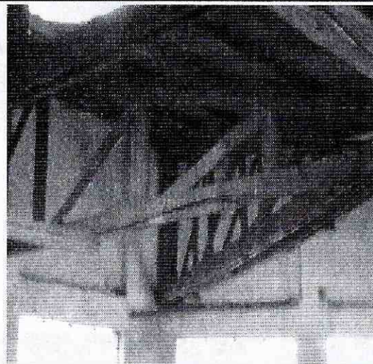
Fotografías 7 y 8. Se observa la cubierta a media altura del muro evaluado, apoyada sobre estructura en madera.
