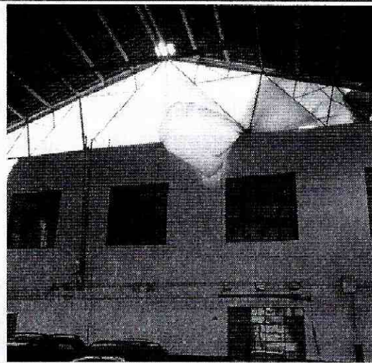
Fotografías 5 y 6. Se observa costado occidental del predio, el cual presenta muros parcialmente demolidos y muros nuevos en mampostería en bloque de arcilla.
