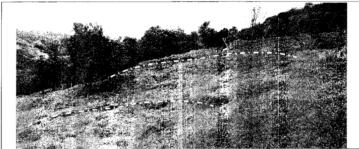
Fotografía 1. Procesos de inestabilidad del terreno que se presentan hacia la parte alta del predio denominado Finca El Codito de la Vereda Tunal Bajo, Corregimiento de San Juan, Localidad de Sumapaz.
