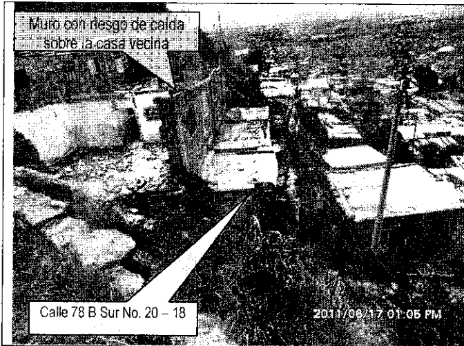
Foto 1. Predio de la Calle 78 B Sur No. 20 – 18, barrio Cordillera Sur de la localidad de Ciudad Bolívar, el cual presenta riesgo por posible caída de muro de la casa vecina.
