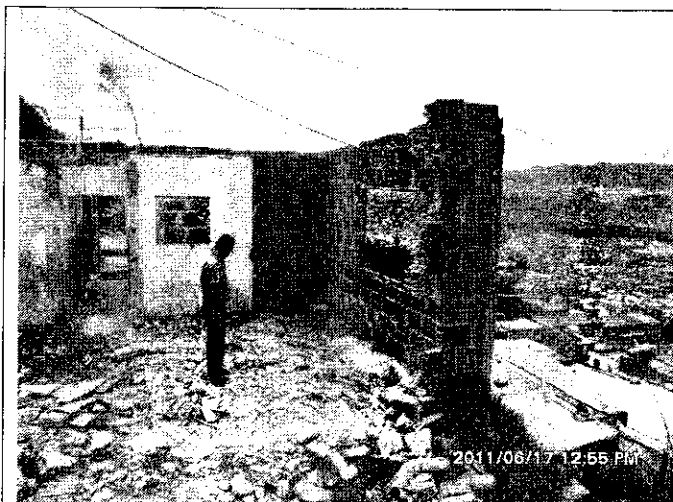
Foto 3. Se puede observar que el muro no cuenta con columnas ni vigas de amarre y presenta movimiento al tacto.
