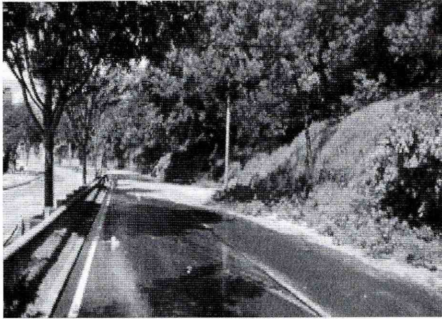
Foto 3. Zona donde se presentó el proceso de remoción en masa 2.
