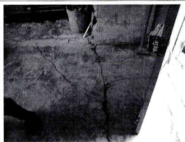
Foto 4 y 5. Afectaciones evidenciadas al interior de la vivienda emplazada en el predio de la Calle 1A # 2A - 48 Este sobre el piso en mortero afinado, evidencia de agrietamientos severos y desplazamiento vertical en la placa.
