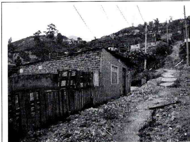
Foto 2. Vista de la fachada frontal de la vivienda emplazada en el predio de la Calle 1A # 2A - 48 Este. En la parte posterior de la vivienda esta la ladera afectada por el proceso de reptación
