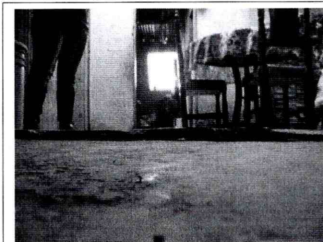
Foto 4 y 5. Afectaciones evidenciadas al interior de la vivienda emplazada en el predio de la Calle 1A # 2A - 48 Este sobre el piso en mortero afinado, evidencia de agrietamientos severos y desplazamiento vertical en la placa.
