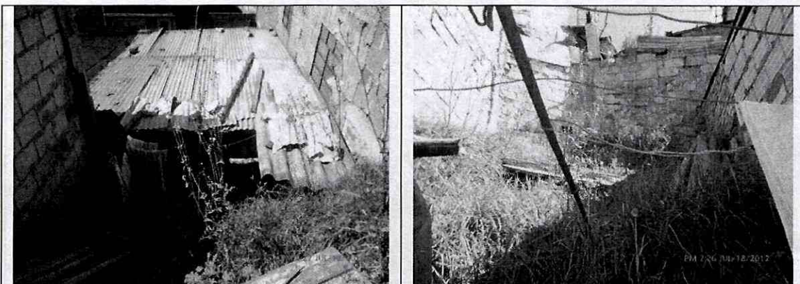
Foto 3 y 4. Vista hacia el costado sur (posterior) de la vivienda emplazada en el predio de la Calle 32 Bis Sur # 15-. Se observa que las condiciones observadas 9 de Septiembre de 2011 no han cambiado considerablemente al 18 de Julio de 2012, con respecto al talud de corte implementado hacia la parte posterior de la vivienda evaluada.
