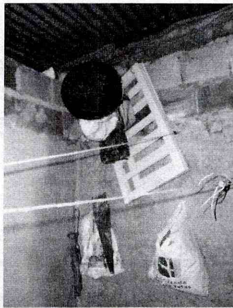
Foto 9. Vista del sistema constructivo de la vivienda emplazada en el predio de la Calle 48Y Sur No. 4-08 Este, la cual se encuentra construida mediante un sistema de mampostería no reforzada no confinada.
