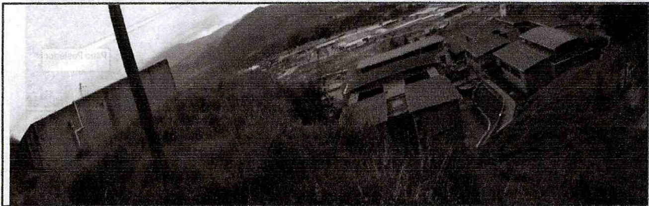
Foto 1. Vista panorámica del Colegio desde el talud de corte, se aprecia a la izquierda el tanque de reserva de agua, emplazado en la parte alta del talud en mención.
