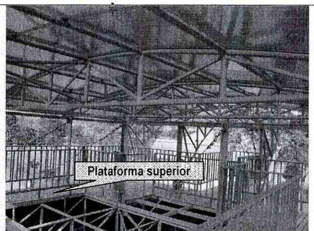
Foto 4. Vista de la cubierta superior, conformada por celosías metálicas con cierre en teja de poliuretano.
