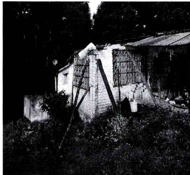
Foto 10. Apuntalamiento con postes de madera en mampostería dado la pérdida de verticalidad en estos elementos.
