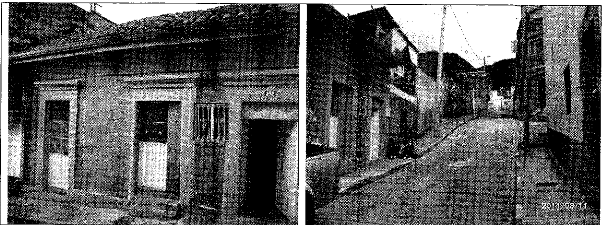
Foto No 2 y 3. Vista desde el exterior de los predios evaluados.
