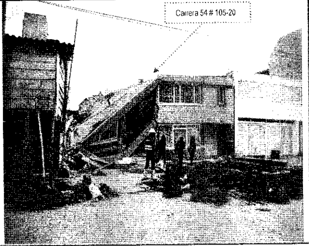
Foto 3. Se observa la estructura de la vivienda parcialmente colapsada.
