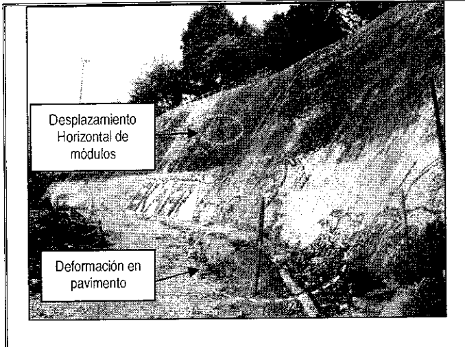
Fotografía 3. Módulos de concreto, utilizados posiblemente para recubrimiento y contención del talud vial, se observa la deformación del pavimento en la pata del talud.
