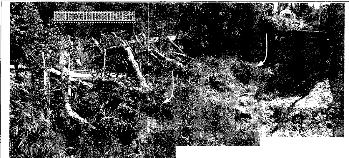
Fotografía 1. Vista general del sector en que se emplaza el predio de la Cr. 17 D Este No. 21 – 16 Sur. Se evidencian los procesos de inestabilidad que afectan la vivienda evaluada.
