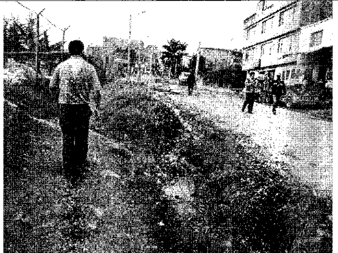
Foto 6. Se evidencia el estado de la vía frente al parqueadero localizado en la Carrera 4 No. 189A – 21 la cual carece de cunetas y demás medidas para el manejo de aguas de escorrentía superficial. Diciembre 1 de 2010.
