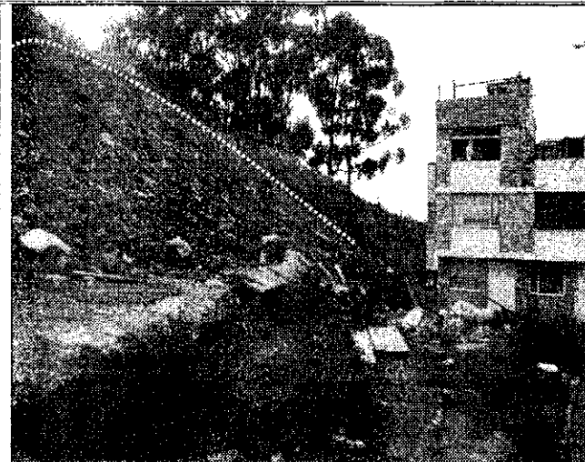
Foto 5. Deslizamiento 2 Ubicado hacia el costado Occidental de la Urbanización Buenavista oriental II sector Etapa II, identificado en el DI-5541 y sobre el cual se observó avance el día 11 de Marzo de 2011
