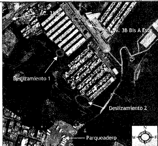
Figura 2. Aerofotografía del sector donde se localiza la Urbanización Buenavista Oriental II Sector Etapa I y II, en donde se ubican los procesos de remoción en masa identificados en la visita realizada al sector.
