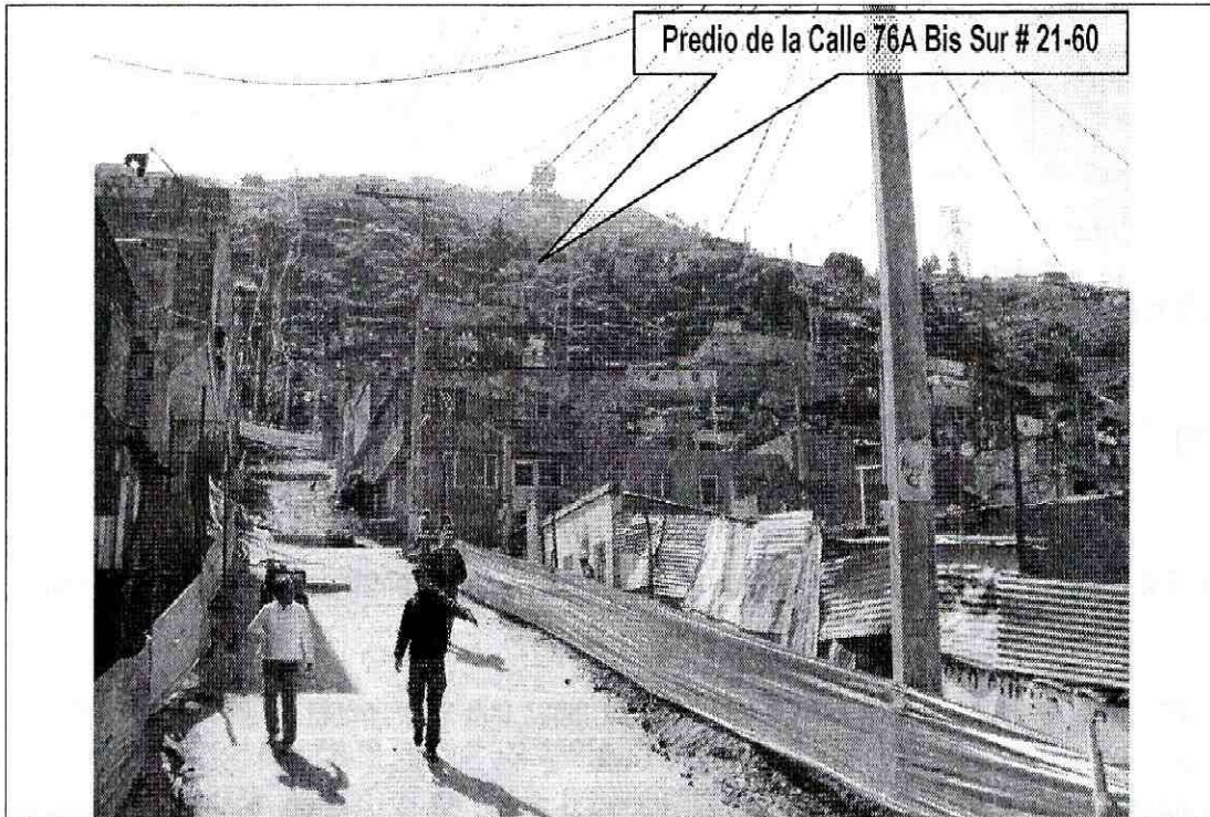
Foto 1. Vista general de la ladera donde se ubica el predio de la Calle 76A Bis Sur # 21 – 60 Barrio Cordillera del sur de la Localidad de Ciudad Bolívar.
