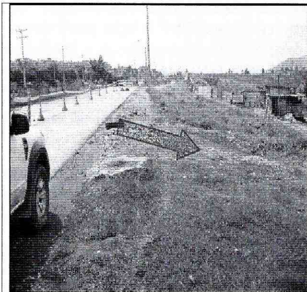
Foto 1. Vista terraza 1 vía al Llano sector de las Carrera 5 entre Calles 72D Bis y 73 Sur donde no se evidencian obras para el manejo del drenaje superficial
