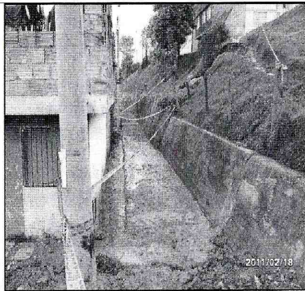
Fotos 6. Vista de la pantalla construida en concreto y de la vía localizada en la parte baja de la ladera (terrazza 3), donde se depositó el material el cual fue removido por la Alcaldía Local de Usme y la empresa de aseo del Distrito.
