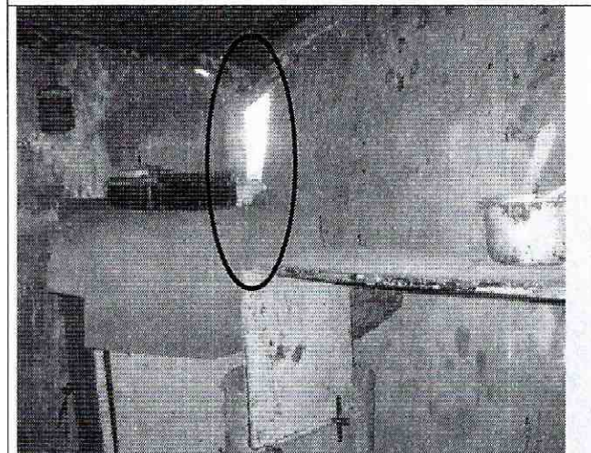
Foto 6 y 7. Se observa la rotura esquinera y grieta del muro de cerramiento lateral de la vivienda afecta.
