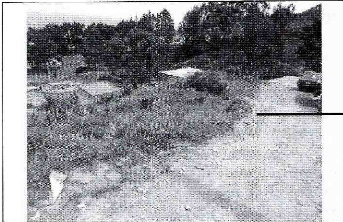
Foto 3 Vía Local carrera 15 A entre Diag 56G y Calle 69G ubicada en la parte alta de de ladera.
